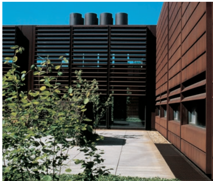
Éclairage pour Flos Spots sur rails , pour boutiques et bureaux. Université d'Odense Couverture caractéristique en plaques d'acier corten du bâtiment de l'université.
